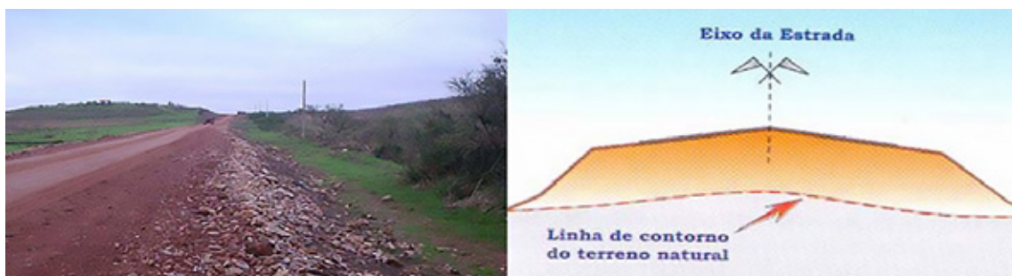
Figura 5 – Trecho de obra rodoviária: Seção em aterro
