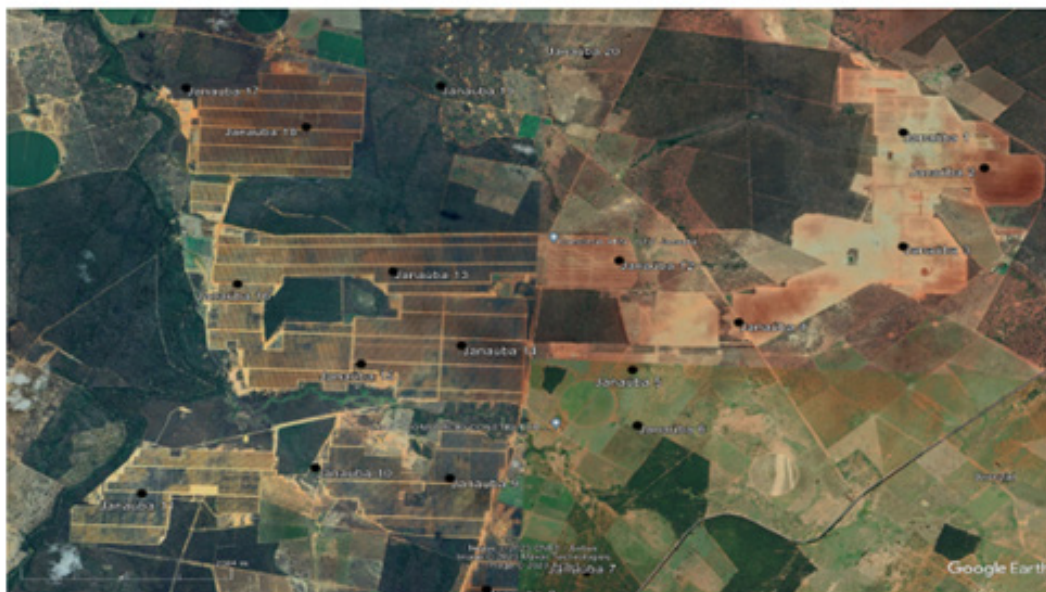
Figura 3 – Localização das usinas do Complexo Solar Janaúba
